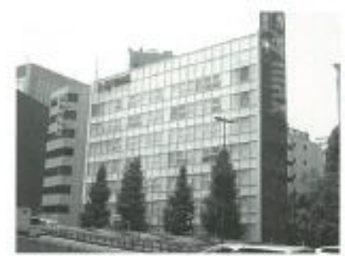
Aランクの認証を得たザイマックス湯池山王ビル。1970年竣工は先行認証を受けた38物件なかで最も古い
